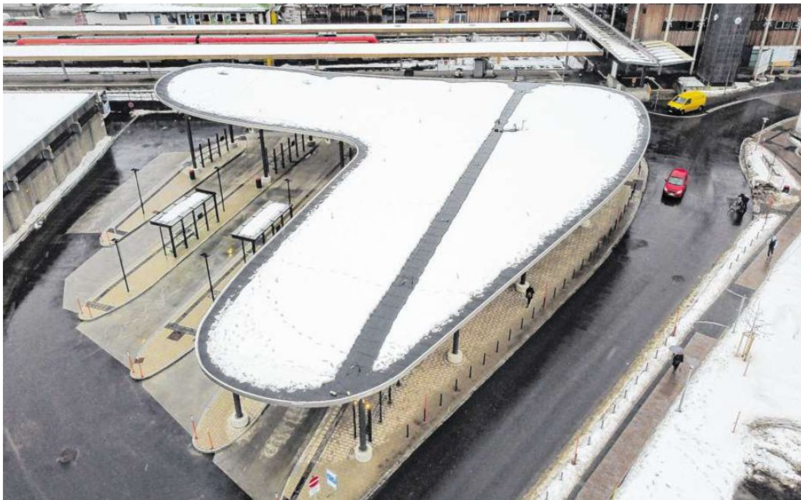
Direkt am Oberstdorfer Bahnhof ist das neue Mobilitätszentrum mit acht Haltestelle entstanden. Durch die moderne Dachkonstruktion können die Fahrgäste künftig trockenen Fußes in den Bus gelangen.
