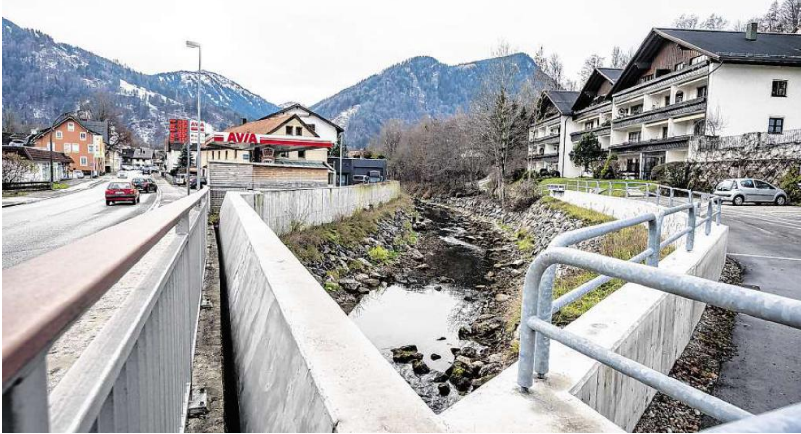
Betonmauern rund um die Konstanzer Ach, um im Falle eines Hochwassers den Anwohnern Schutz zu bieten: Im Hintergrund wurde auch die Waschkabine der Tankstelle abgebrochen und neu gebaut (dunkles Gebäude). Foto: Dominik Berchtold
