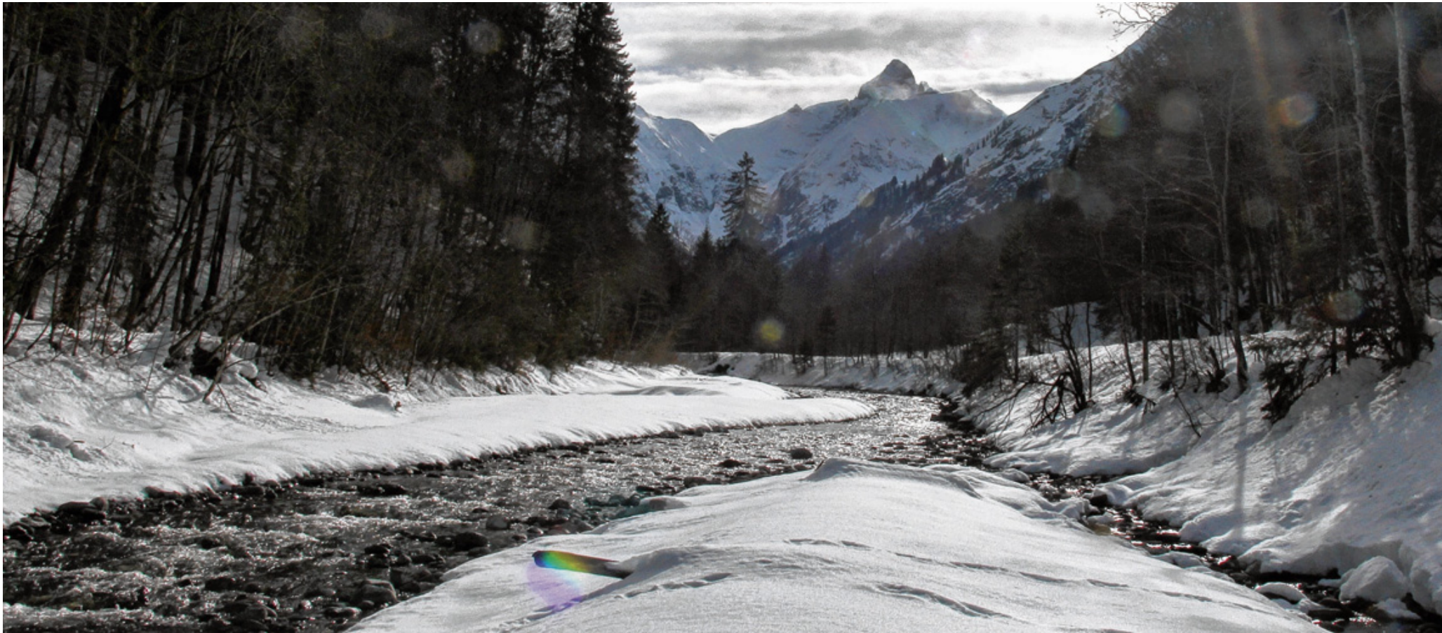
An der Trettach in Oberstdorf soll ein neues Wasserkraftwerk errichtet werden, an dem die Gemeinde mit 30 Prozent beteiligt ist. Die Pläne stoßen aber auch auf Kritik, denn im Trettachtal liegt auch das zentrale Trinkwassergewinnungsgebiet für die Gemeinde Oberstdorf. Archivfoto: Charly Höpfl
