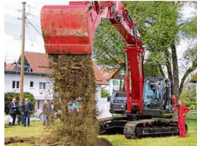
Mit dem ersten Baggerbiss gab Oberbürgermeister Dr. Ivo Holzinger den offiziellen Startschuss für den 1,6 Millionen Euro teuren ersten Bauabschnitt der neuen Abwasseranlage in Dickenreishausen. Foto: Mayer/Pressestelle Stadt Memmingen
