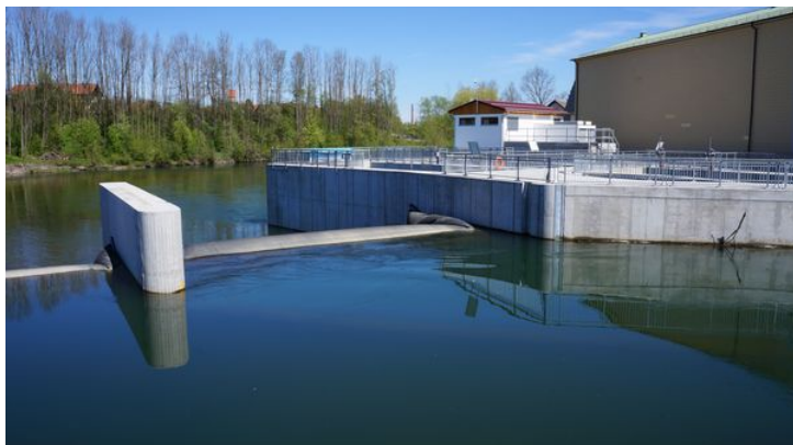
Das neue VLH-Wasserkraftwerk in Sulzberg/Au. (Foto: Ingenieurbüro Koch)
