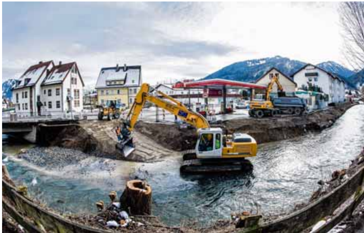
An der Avia-Tankstelle in der Kemptener Straße in Immenstadt haben sich die Bauarbeiter einen Zugang in die Konstanzer Ach geschaffen. Dort wird das Flussbett freigelegt, damit es bei Hochwasser nicht zu Überflutungen kommt. Foto: Dominik Berchtold
