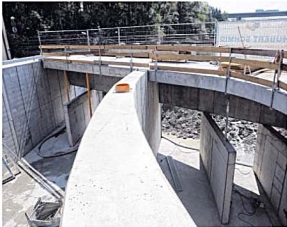
Ein Blick ins Kraftwerk: Dort fließt das Wasser hinein zu den beiden langsam drehenden Turbinen. Kleine Fische können da durchschwimmen, größere schwimmen drüber. Ende Oktober werden die Turbinen eingesetzt.
