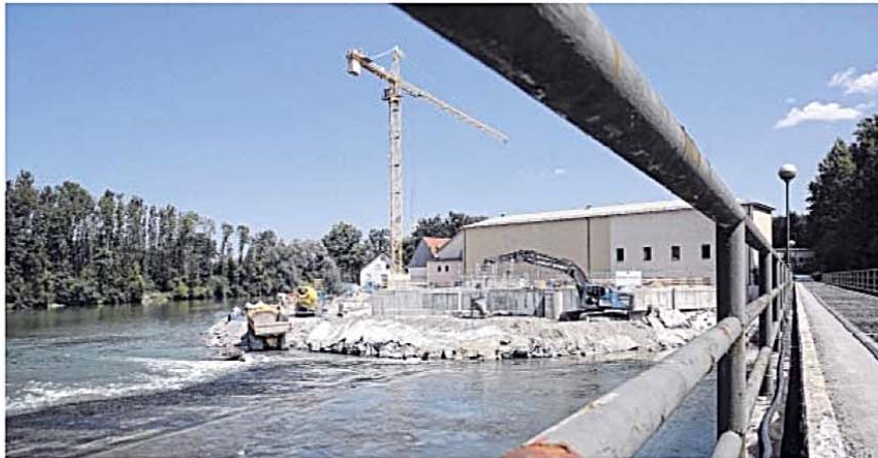
Blick vom Betriebssteg des Allgäuer Überlandwerks auf die Kraftwerksbaustelle. Links im Fluss war das ehemalige Wehr, das demnächst durch ein Schlauchwehr ersetzt wird. Während der Bauarbeiten wird das Illerwasser durch einen Damm nach rechts umgeleitet und fließt dann bereits durch das noch im Bau befindliche Wasserkraftwerk. Fotos: Matthias Becker
