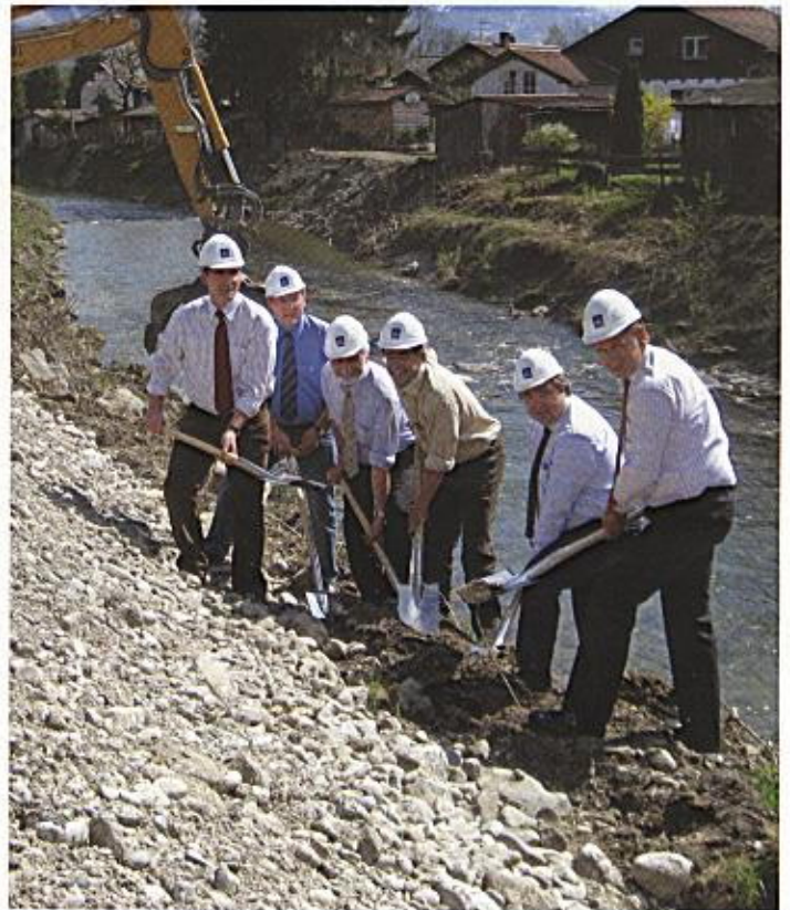
Spatenstich für die Fortsetzung des Hochwasserschutzes am Schwarzenbach mit (von links) Otto Steiger, Wolfgang Arnoldt, (Leiter Wasserwirtschaftsamt), Herbert Seger, (Vize-Landrat), Mathias Kappeler, (Ingenieur Büro Dr. Koch Kempten), Roland Filippi, (Geschäftsführer Baufirma Hebel) und Friedrich Megerle (technischer Werkleiter Bosch).
