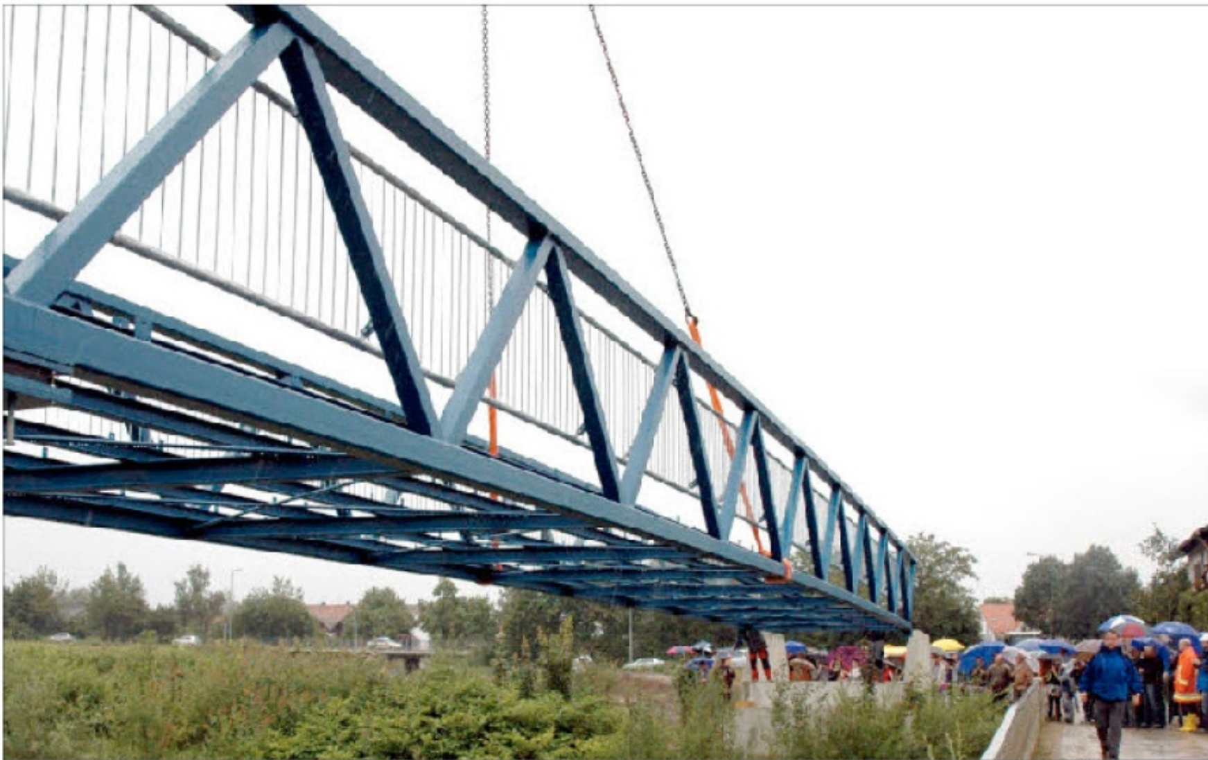
Die neue Rottbrücke am Fischerweg wurde gestern eingehoben – zahlreiche Schaulustige verfolgten das Spektakel.
