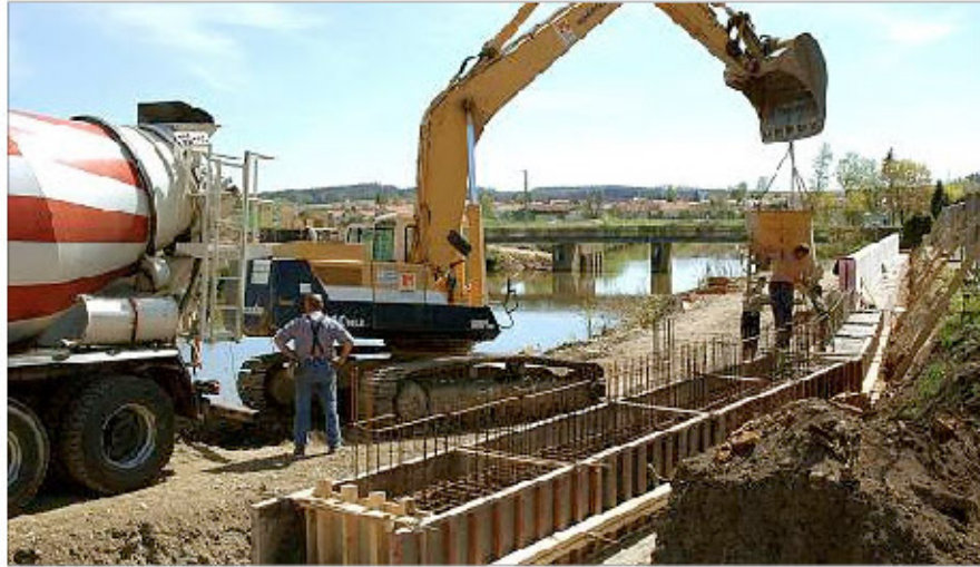
Im Bereich der P+R-Anlage (Festwiese) entsteht gerade die Hochwasserschutz-Mauer.
