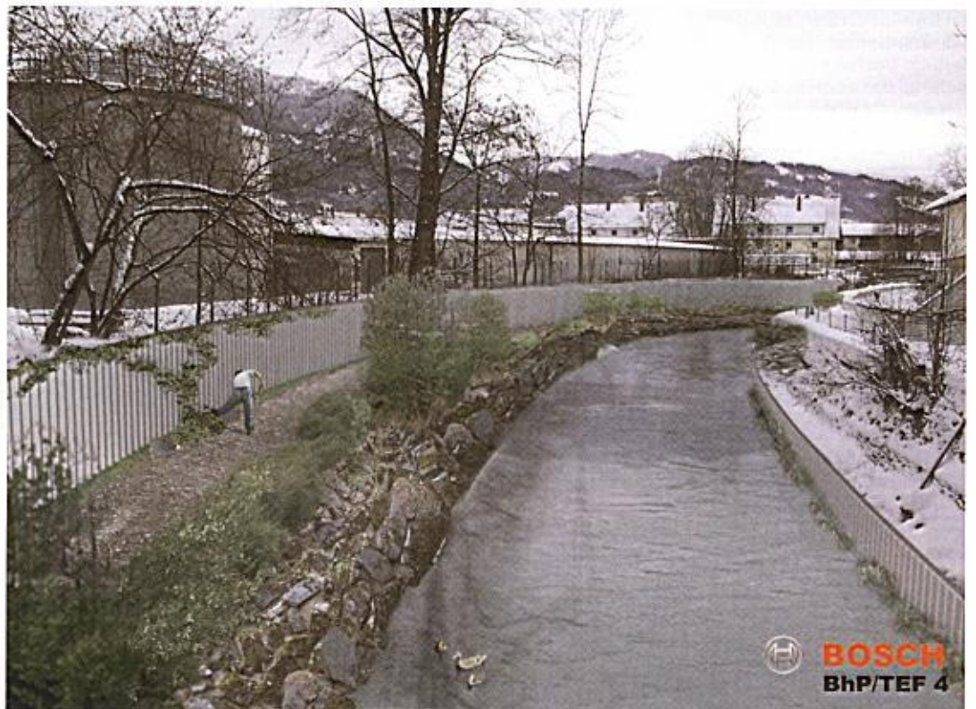
Nach Abschluss der Eintiefung und Bau des Freibords wird der Schwarzenbach so aussehen. (Fotomontage: Bosch)
